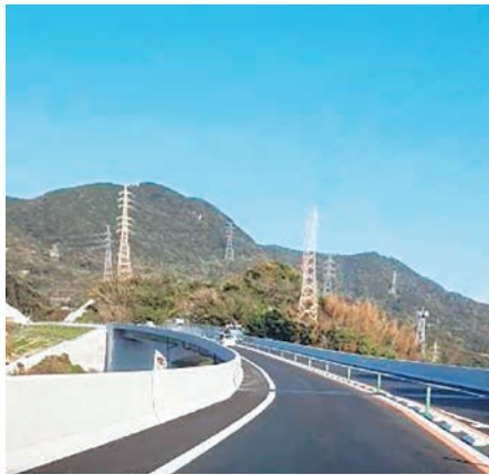
開通後の西彼杵道路（時津工区）
