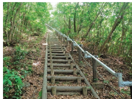
崎野自然公園遊歩道手摺設置工事
