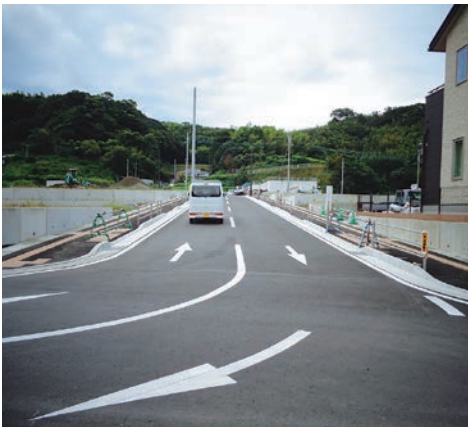
9月4日に開通した西時津浜田線
