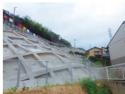
元村郷上開田地区急傾斜地崩壊 対策事業
