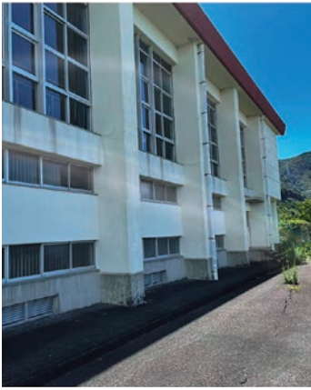
時津中学校体育館
